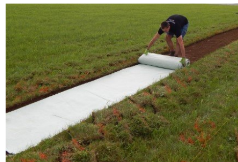
Pokládka sendviče senzoru
